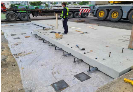
그림 2. 버스차고지 조립식 포장 적용
