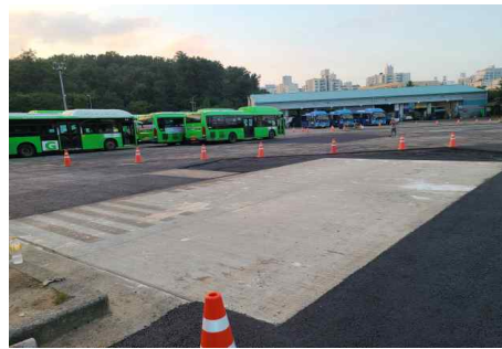
그림 2. 버스차고지 조립식 포장 적용
