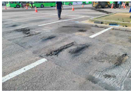
그림 1. 버스차고지 포장 파손 현황
