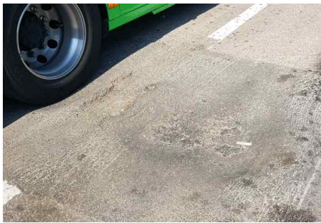
그림 1. 버스차고지 포장 파손 현황
